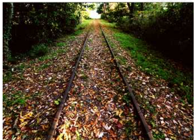
西武鉄道安比奈線（埼玉県）
