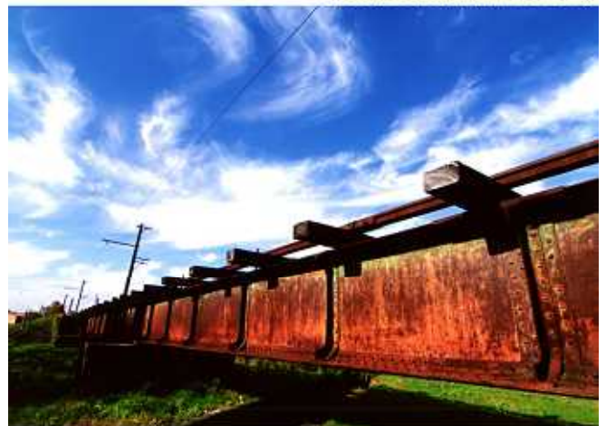
西武鉄道安比奈線（埼玉県）
